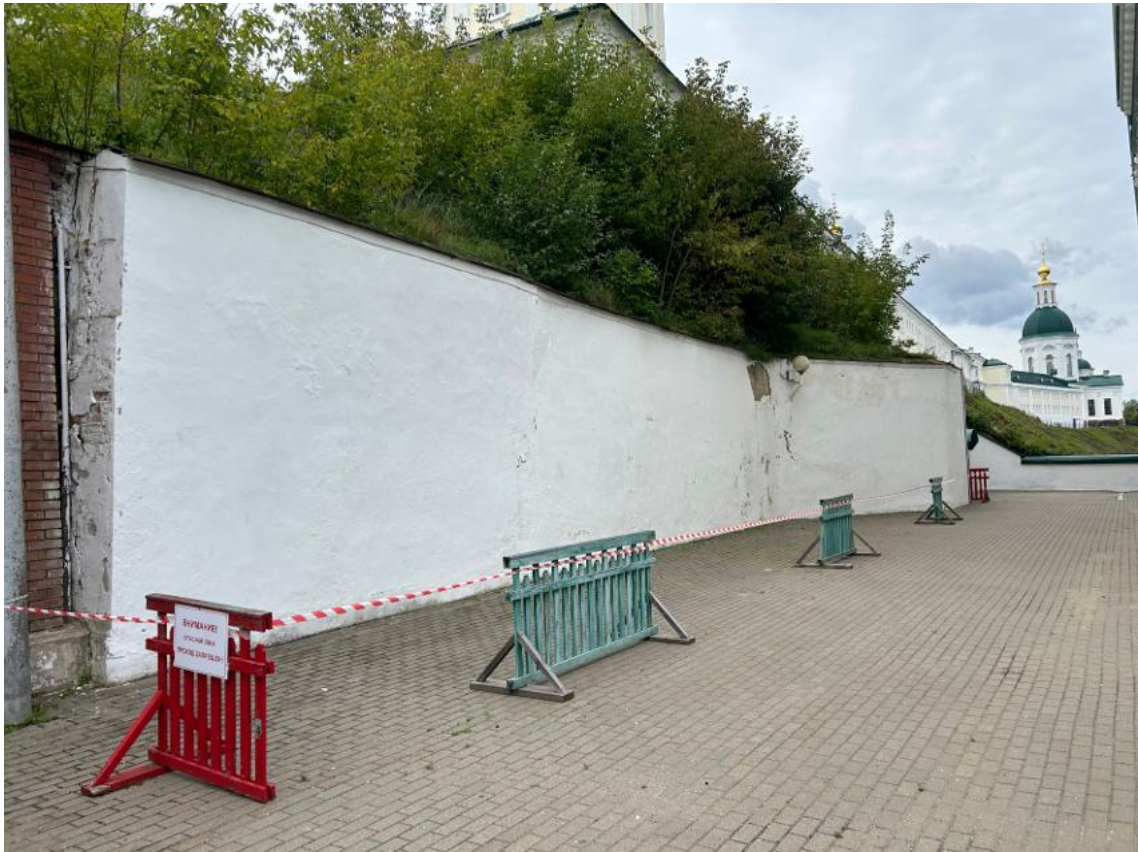
Илл. 19. Нижегородская область, г. Саров, пр. Мира, 17а, инженерные исследования при воссоздании лестницы - 2026 г. Видовые фотографии участка инженерных исследований (предоставлены заказчиком).
