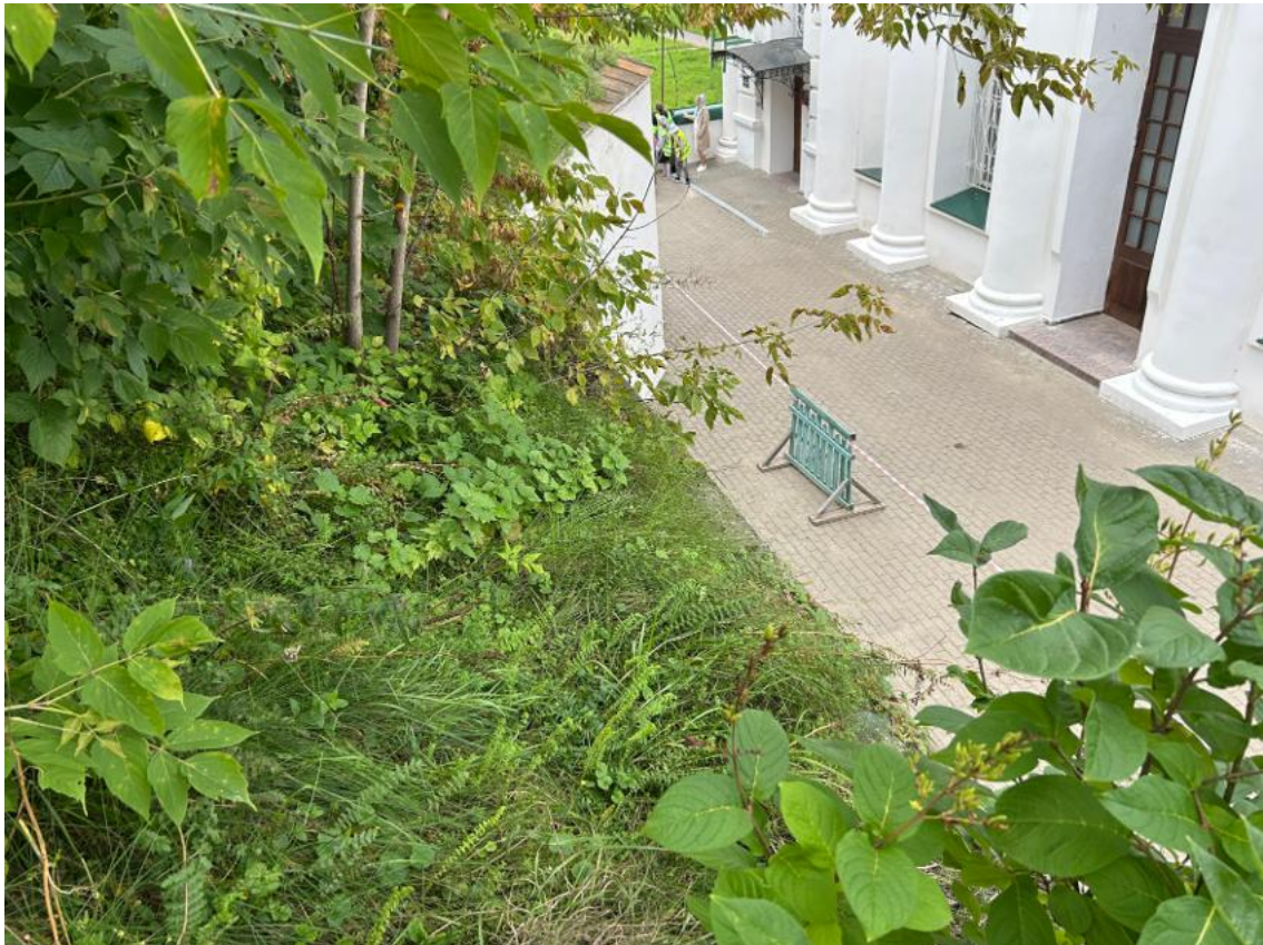
Илл. 20. Нижегородская область, г. Саров, пр. Мира, 17а, инженерные исследования при воссоздании лестницы - 2026 г. Видовые фотографии участка инженерных исследований (предоставлены заказчиком).
